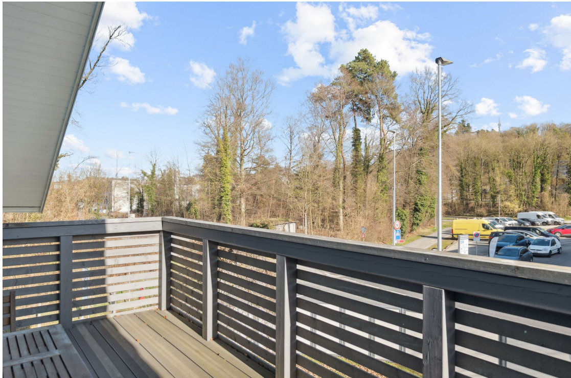
Balkon im Obergeschoss
