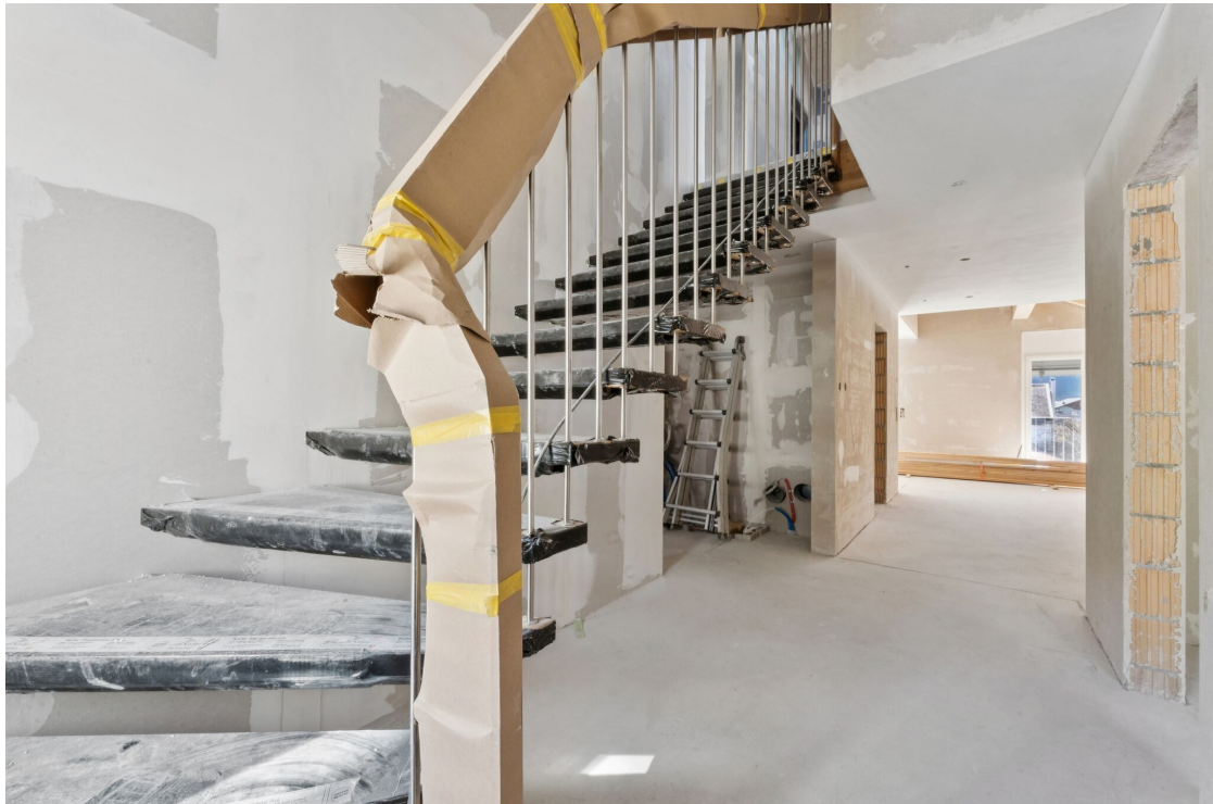
Escalier menant à l'étage supérieur
