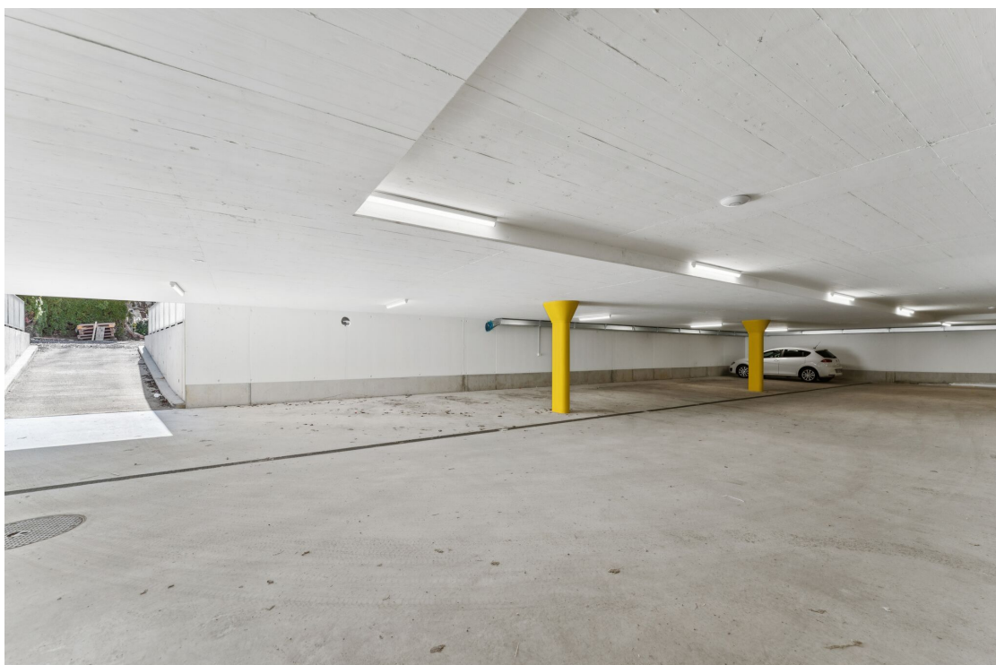
Places de parc dans les garages
