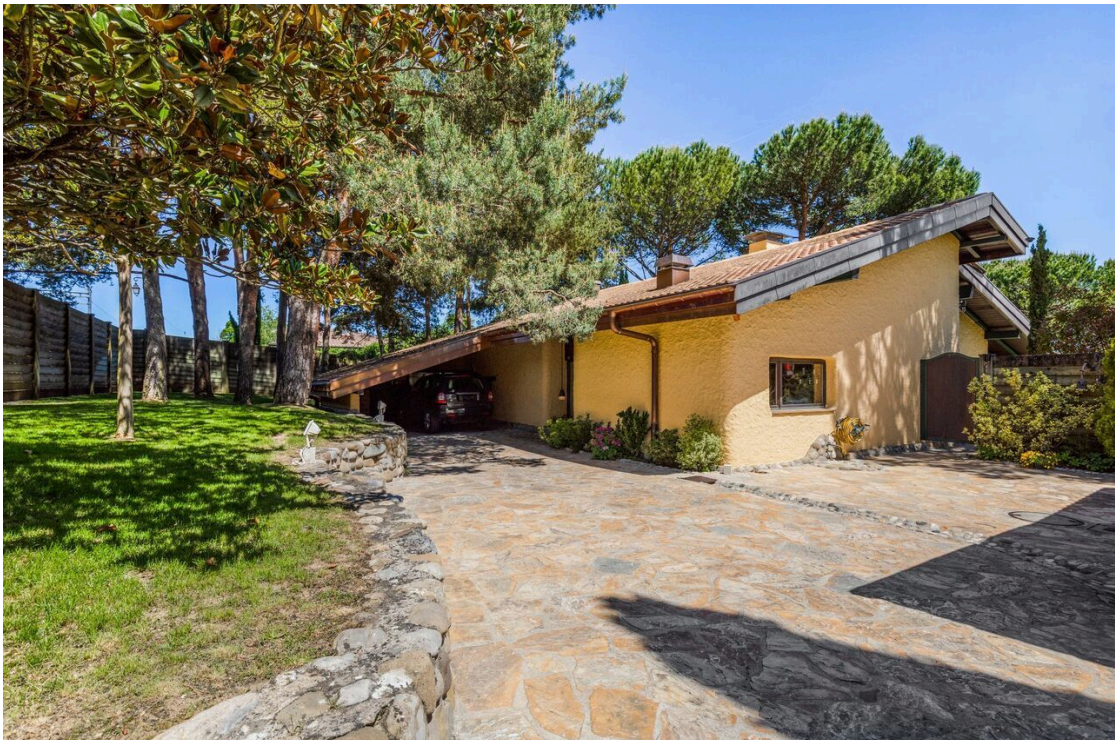
Entrée et cour d'entrée
