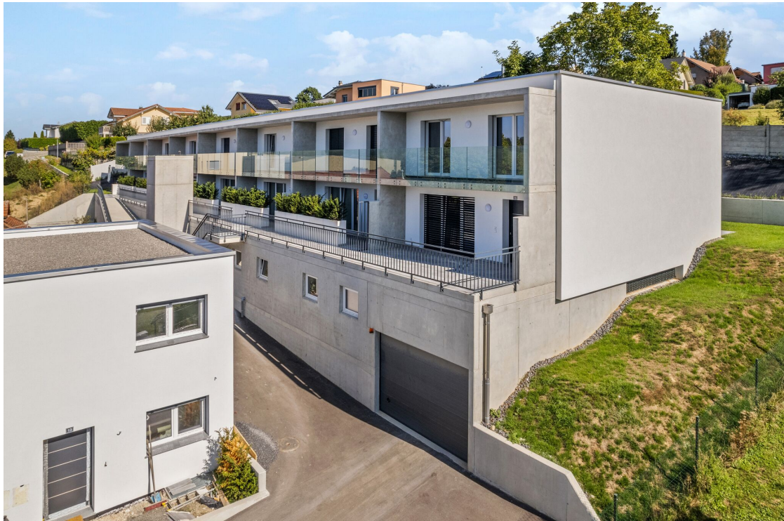
Vue entrée, terrasse, balcon et entrée garage
