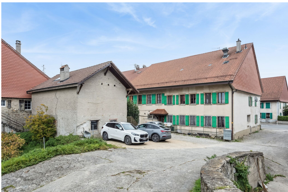
Vue extérieure depuis l'arrière
